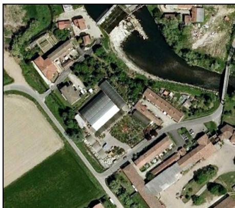
Figura 37. ATCf-PII 1. Foto aerea
